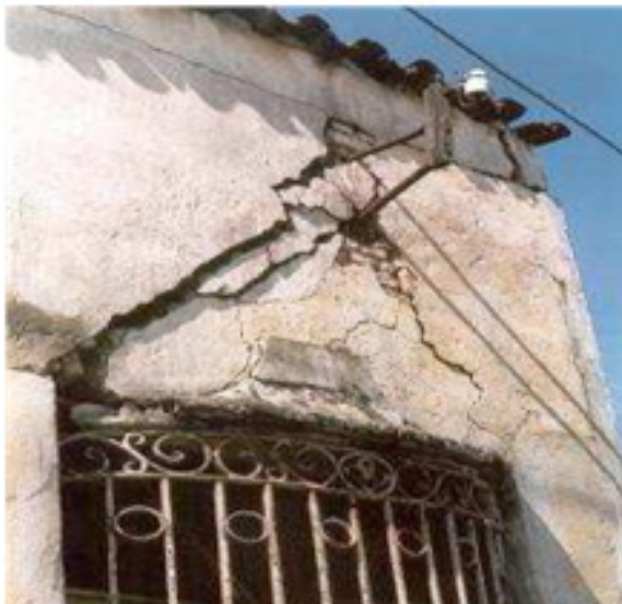
Figura 2: Deteriorações que afetam a durabilidade do património edificado devido a um dimensionamento inadequado, impermeabilização e proteção deficientes contra a chuva, má aderência do material de reboco, etc. Fonte: self-made
